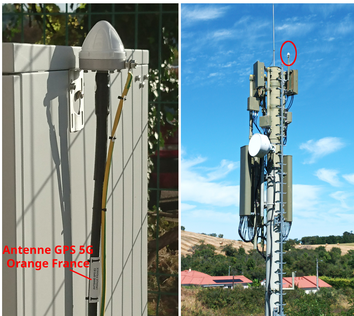
FIGURE 18 – Deux exemples d’antennes de réception de signaux de navigation par satellite pour la synchronisation en temps des stations de base de téléphonie mobile, à gauche sur le campus scientifique de l’université de Franche-Comté à Besançon, à droite dans la banlieue de Clermont-Ferrand (antenne au sommet du pilône entourée en rouge).
